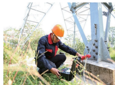
铁塔接地电阻测量
