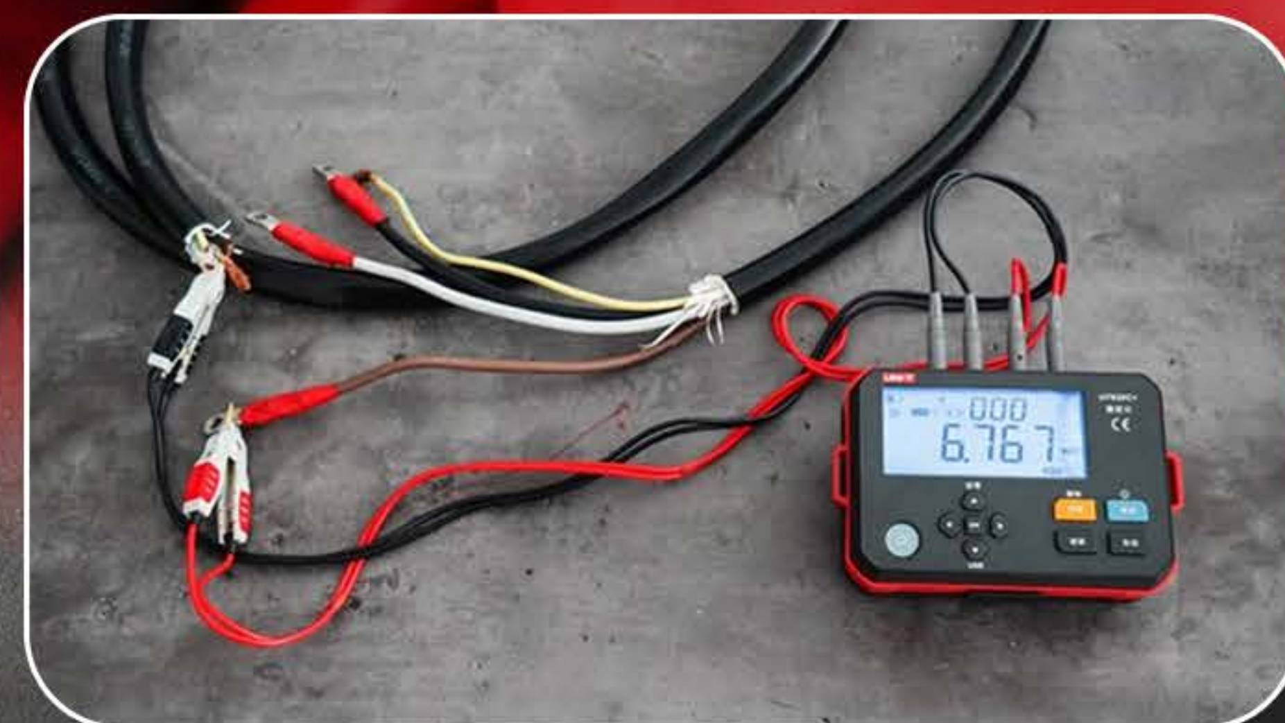
电缆线阻测量
