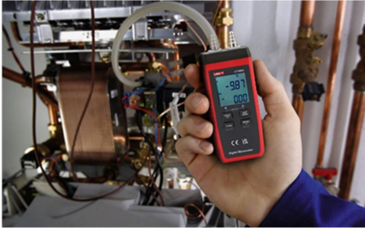
空调系统压力测试
