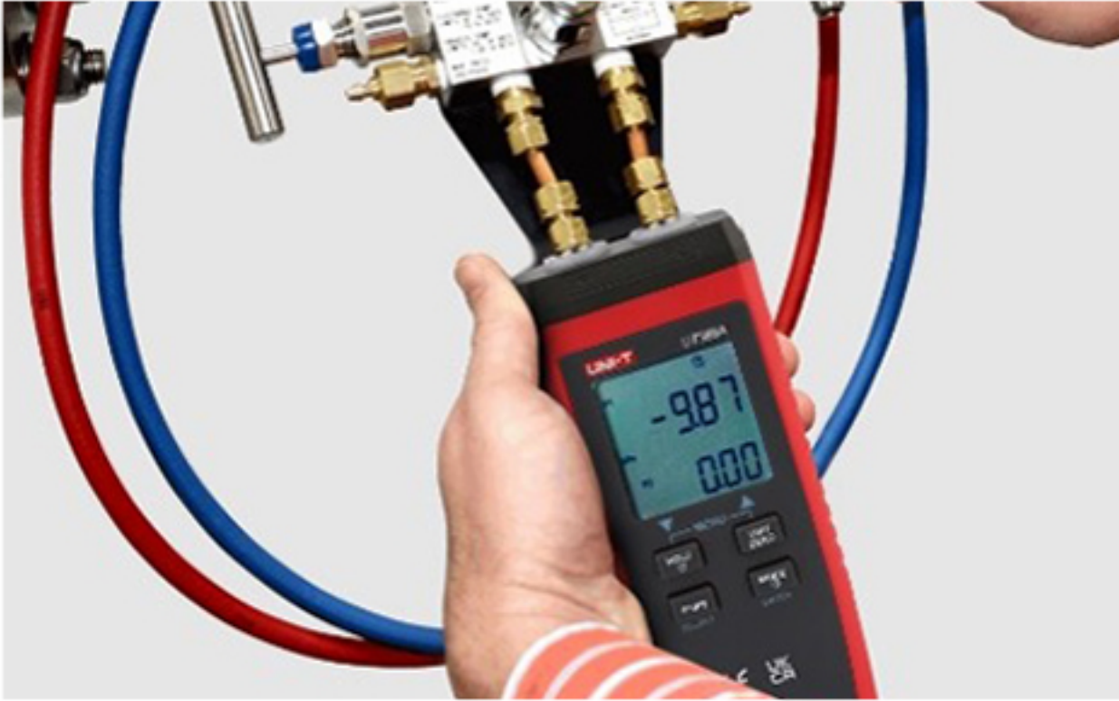
管道气压测试
