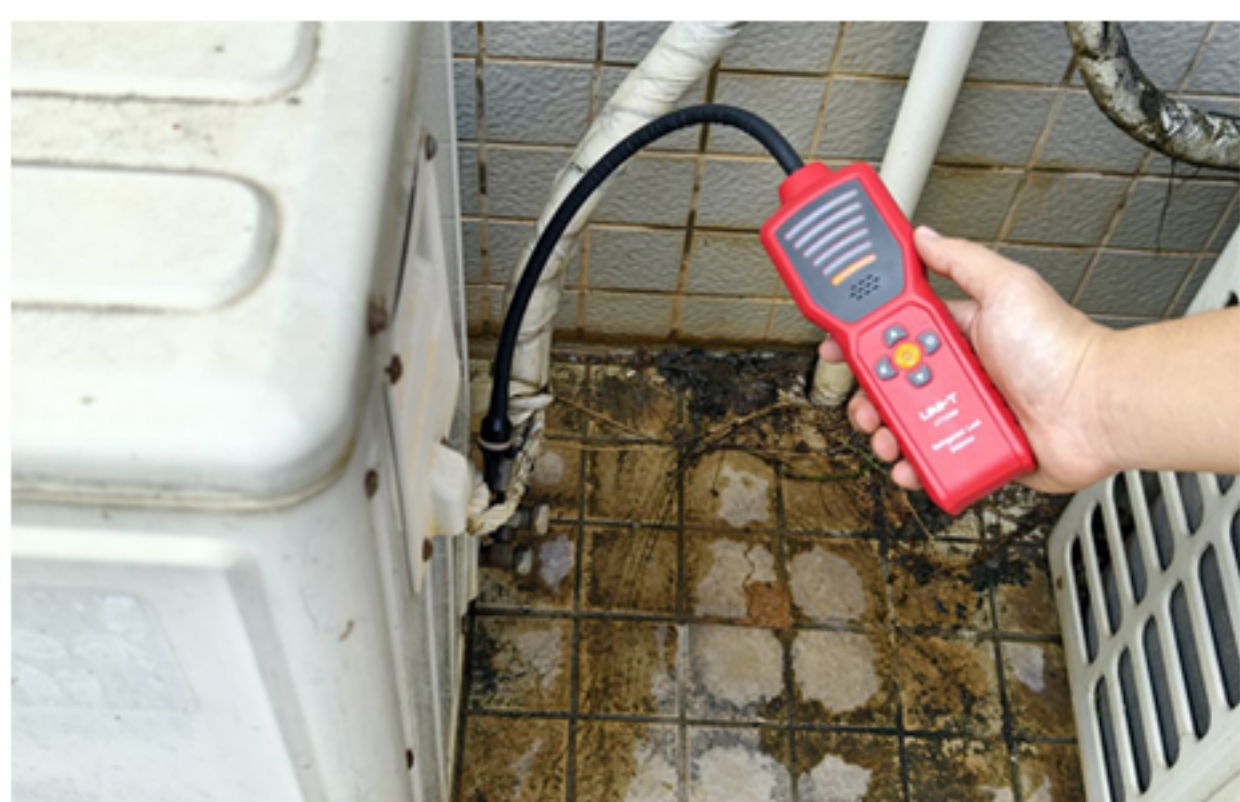
空调冷媒检漏
