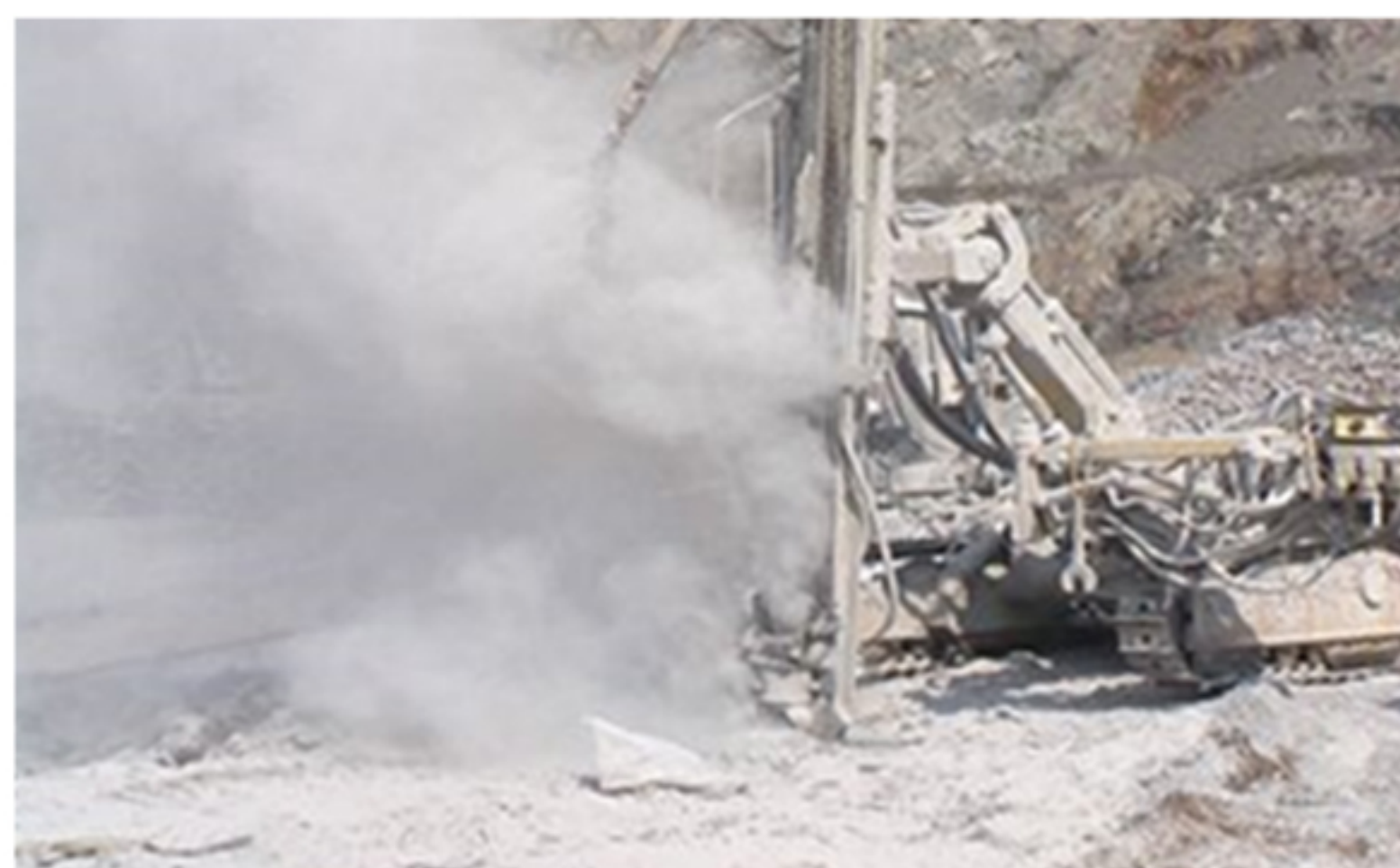
在工程建设等环境中测量
